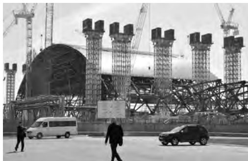
Kyoto ウクライナ北部チェルノブイリ原発で、事故を起こした4号機の石棺を覆うために建設が進む巨大ドーム
